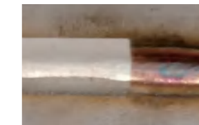
不锈钢焊缝氧化层清洗
